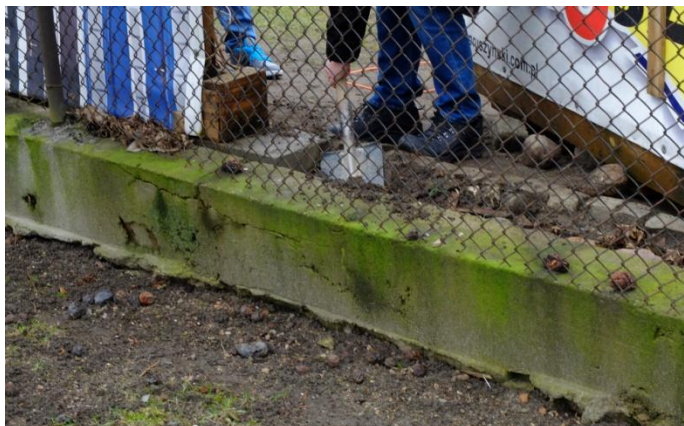
Rys. 5. Przygotowanie podmurówki do pobrania próbek oraz wykonania odkuwek.
