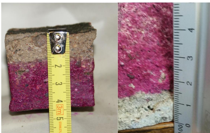
Rys. 7. Pomiar głębokości karbonatyzacji na odkuwce i fragmencie odwiertu.
